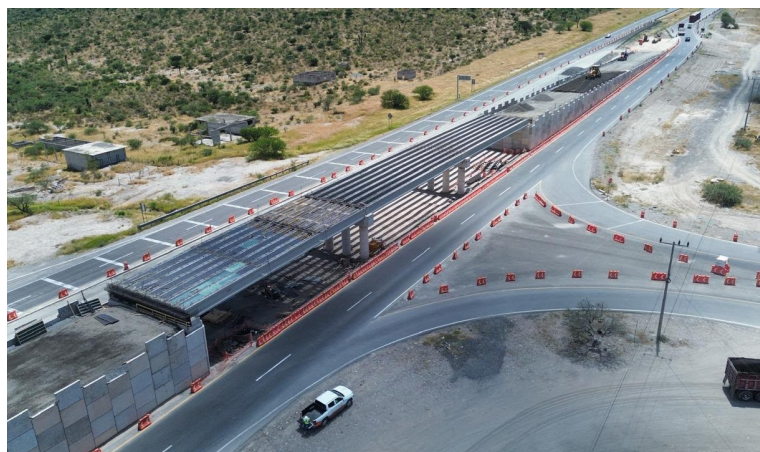
OBRA. Se reporta trabajos en los entronques de Villa de Arista, El Peyote y Matehuala.
