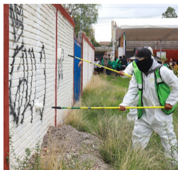
INTERVENCIÓN. Se realizan trabajos de mejoramiento de espacios.
