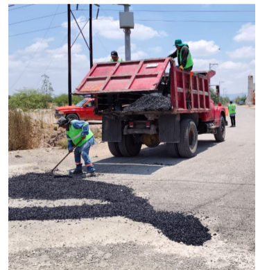
MELJORAS. Se realizan labores de limpieza y bacheo, entre otras.
